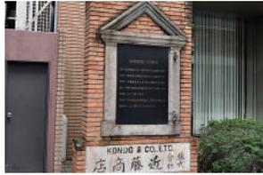
古い建物のレンガ造りの窓周りが伊藤町に残されています。窓枠には重量を支えるために御影石を三角に組んで載せ、レンガは現在のもよりも薄いものが用いられているのがわかります。下の社名板は昭和8年頃のもので、
