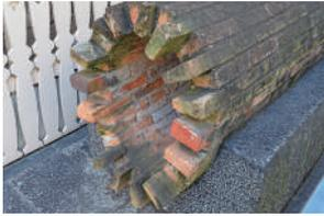
神戸付近で焼かれたレンガを使った居留地の下水道は、円形管と卵形管が南北道路に沿って6本1880mが敷設されました。近代下水道としては日本で一番古いもので、現在でもその一部が下水道の雨水幹線として使われています。
