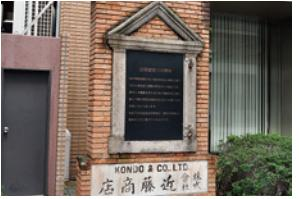
古い建物のレンガ造りの窓周りが伊藤町に残っています。窓枠には重量を支えるために御影石を三角に組んで載せ、レンガは現在のものよりも薄いものが用いられているのがわかります。下の社名板は昭和8年頃のものです。
